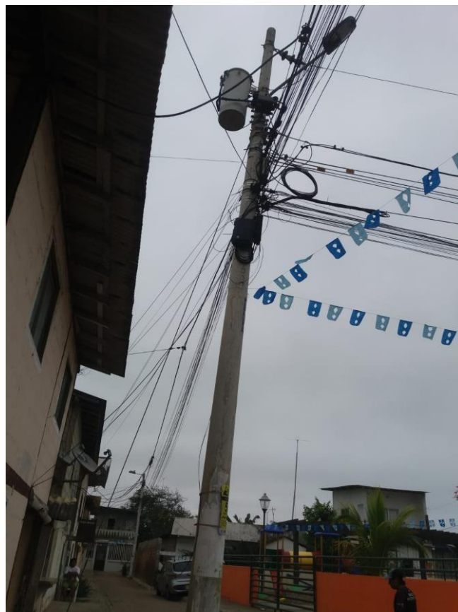
Figura 49: Cableado de redes
