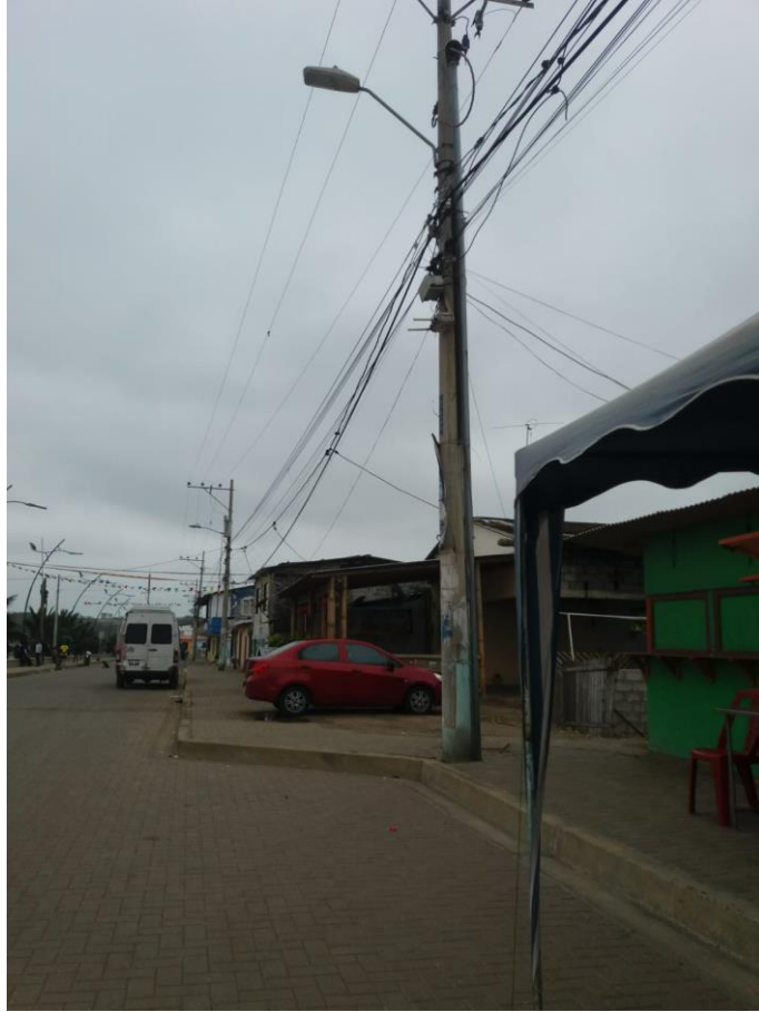
Figura 52: Cableado de redes
