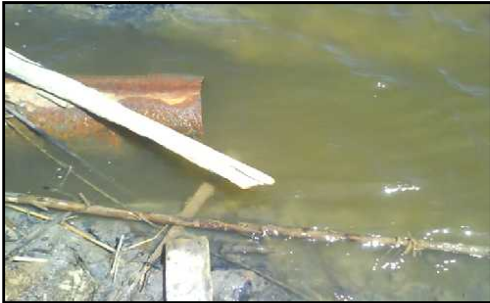
Gráfico 15: Tubería proveniente de la industria harinera que desfoga sus efluentes al estero.
