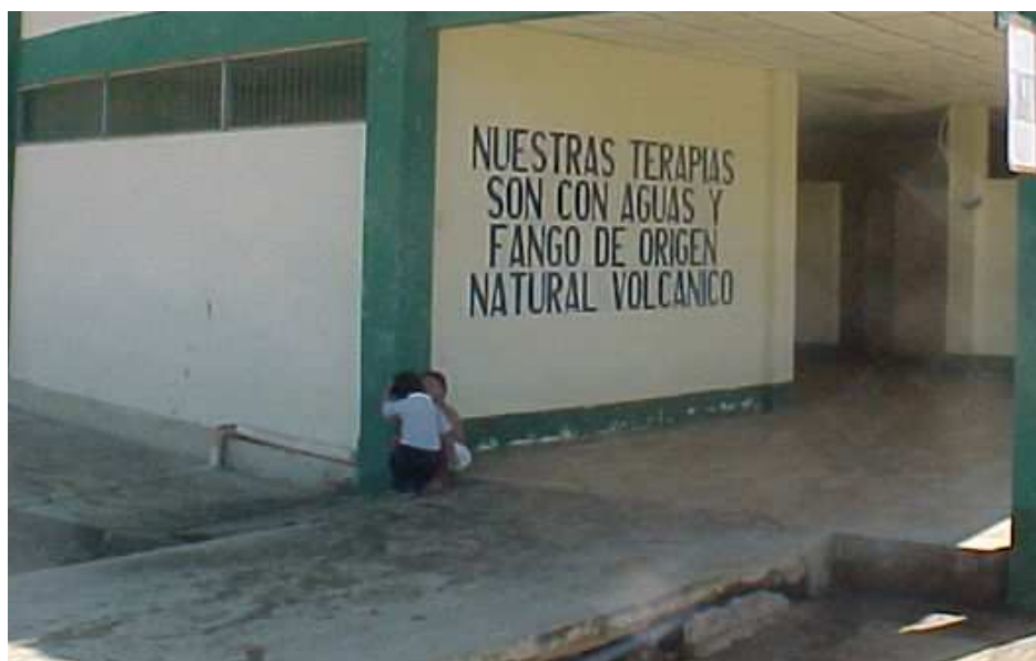
FOTO # 2 PISO EN MAL ESTADO
