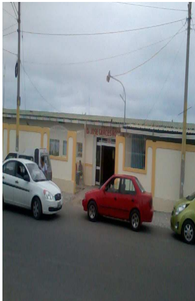
Vista del Hospital José Garcés Rodríguez
