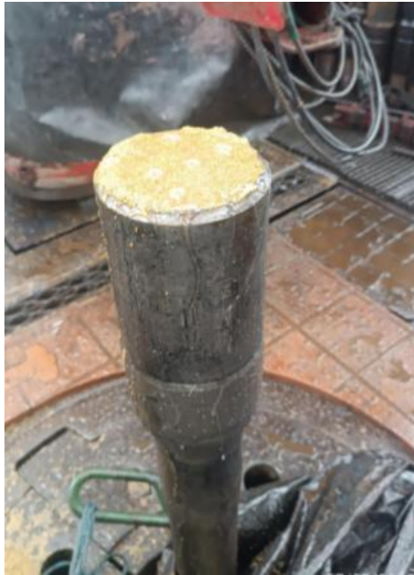
Fig. 28 Operación de limpieza de arena mediante Tubing Bailer.
