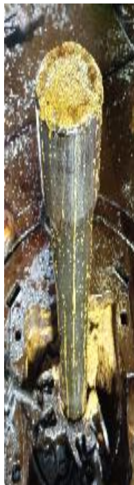
Fig. 41 Operación de limpieza de arena mediante Tubing Bailer.
