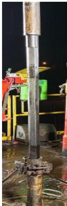
Fig. 39 Operación de limpieza de arena mediante Tubing Bailer.
