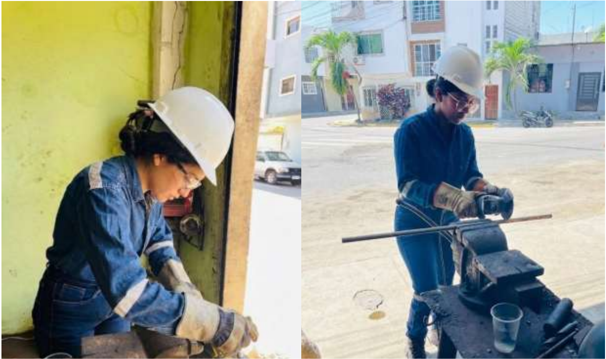
Corte de barra de acero de 1 pulgada para 4 guías de 700 mm para mejor sujeción y estabilidad de estructura
