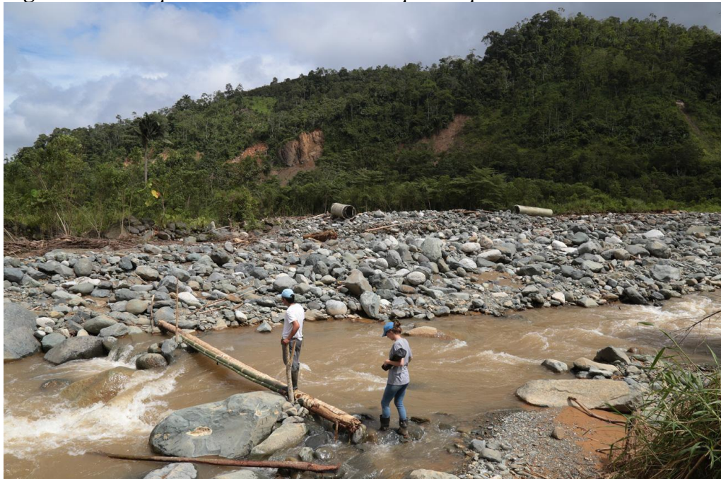
Figura 1. Daños producidos en el río Dulcepamba por la construcción de la hidroeléctrica
