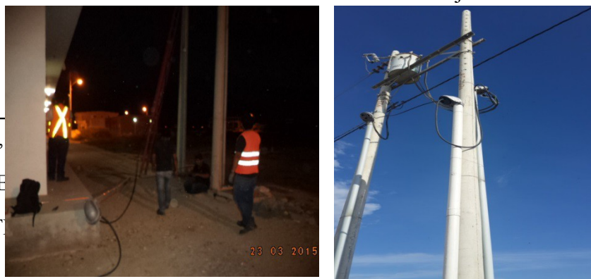
Ilustración 19: Instalación del tubo Bajante
