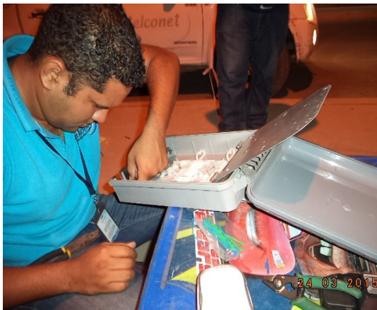
Ilustración 22 Fusión de la FO en el BMX –paso 2-
