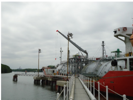
Fotografía 20: Inicio de conexión de manguera del muelle al B/G
