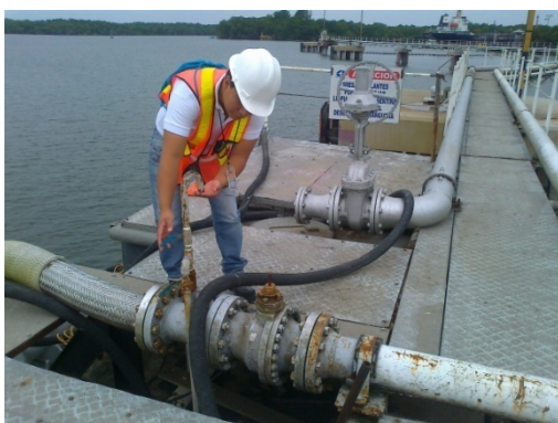
Revisión de la válvula de paso Fotografía 22: John Domínguez González
