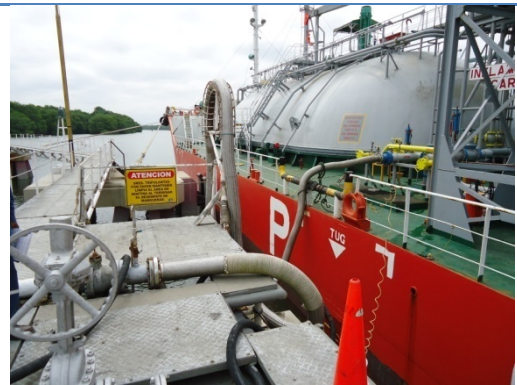
Fotografía 27: Conexión segura del B/G
