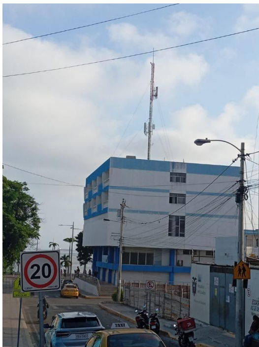
Figura 17. Vista de la estación base de CNT y su torre de telecomunicaciones desde la vía pública.
