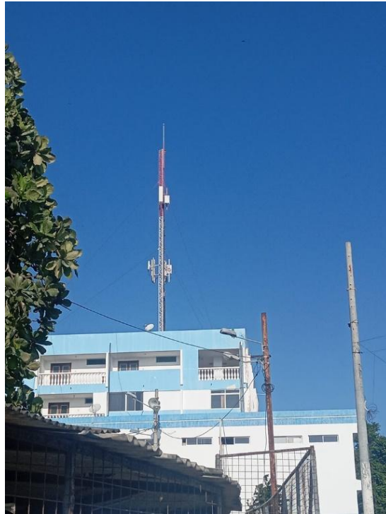
Figura 19. Detalle de la torre y las antenas sectoriales de la estación base LTE analizada.
