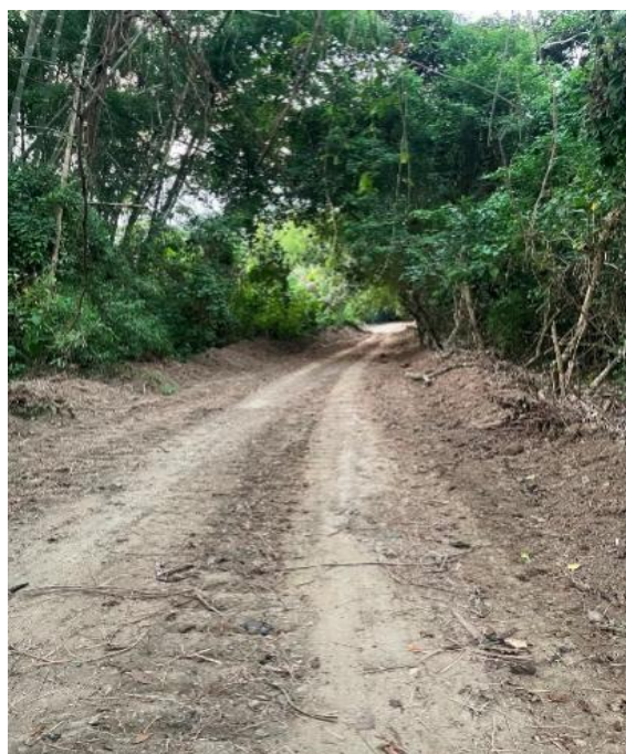
Figura 32. Apertura de camino con maquinaria pesada.
