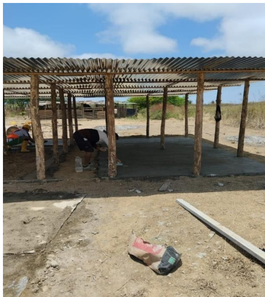
Figura 4A Construcción de los corrales
